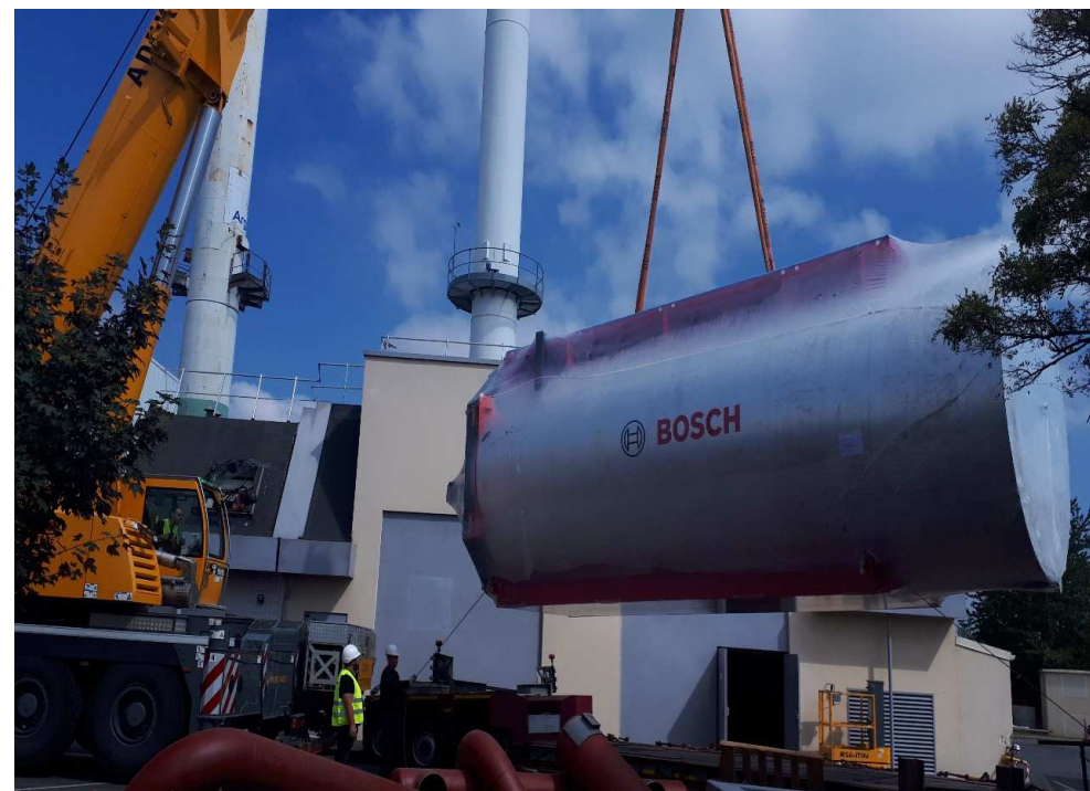
Mise en place de la nouvelle chaudière :
