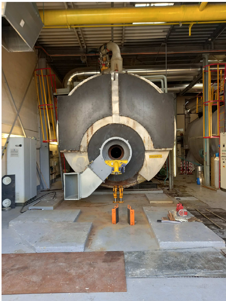
Démantèlement de la chaudière de 13 MW :
